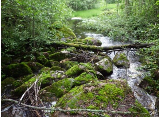
Kuvat 30. Haapajoen alin köngäs ja Kaukolantien siltarumpu.
